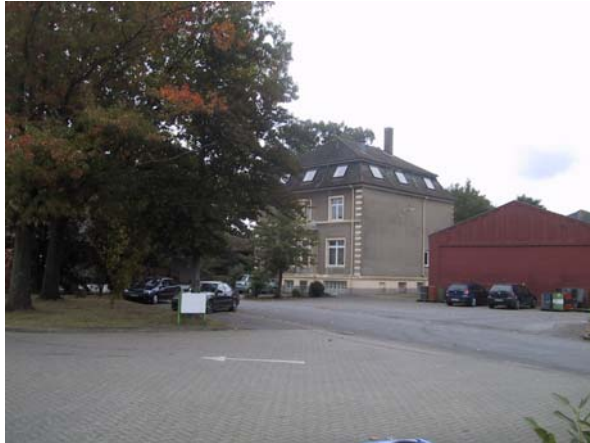
Raiffeisenstraße 8, Blick von Nordwesten
