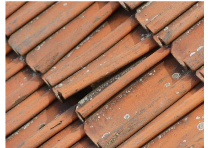
▪ Dachziegel sind verlagert = fehlende Überdeckung
