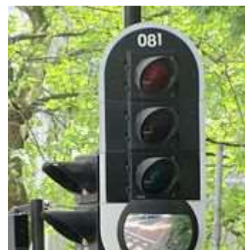
Sog. „Trixi-Spiegel“ an einer Ampelanlage in Amsterdam
