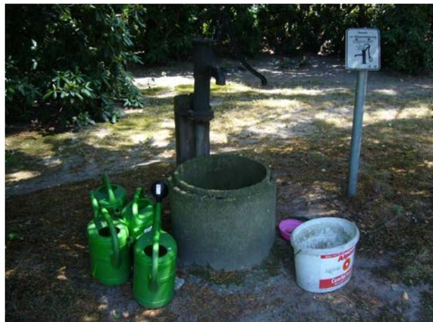
Abb. 258 Beinhorn, Zapfstelle mit Schwengelpumpe (Technik ist alt, aber funktional)
