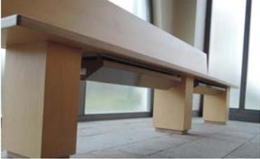
Beispiel einer gut positionierten Wärmequelle,
