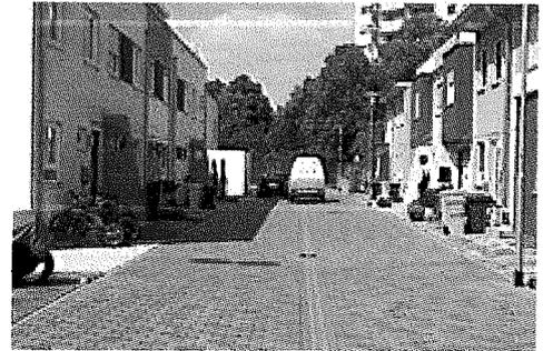
Versickerungsfähiges Pflaster mit aufgeweiteter Fuge in einer Erschließungsstraße
