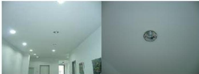
In den Fluren von Rathaus IV wurden insgesamt 37 Halogenleuchtstoffröhren mit einer installierten Leistung von 1.016 Watt entnommen. Rechnerisch können aufgrund der Leuchtmittelentnahme jährlich voraussichtlich 611 kWh Strom eingespart werden. Zusätzlich werden mit dieser einfachen Maßnahme rund 435 Kilogramm CO<sub>2</sub>-Emissionen pro Jahr vermieden.
