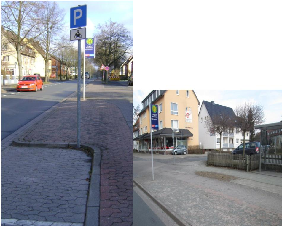
Die Aufstellfläche erfolgt in rotem Betonsteinpflaster. Durch die Lage der Wartehalle muss der Radweg gekreuzt werden um zum Bus zu gelangen. Auf Grundlage der Empfehlungen für Radverkehrsanlagen (ERA) wird der baulich getrennt angelegte Geh- und Radweg im Bereich der Bushaltestelle als gemeinsamer Geh- und Radweg beschildert. Dieser wird in grauem Betonpflaster angelegt.
