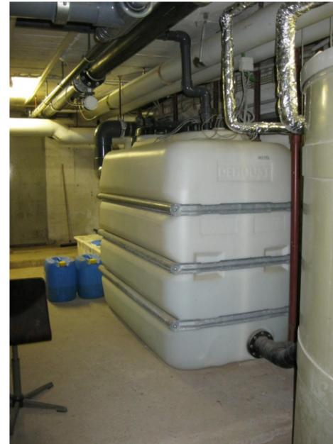
Die Füllstandsmessung für die Regulierung der Nachspeisung und des Trockenlaufschutzes der Schwallwasserpumpe wird über im Behälter installierte Elektroden ermöglicht
